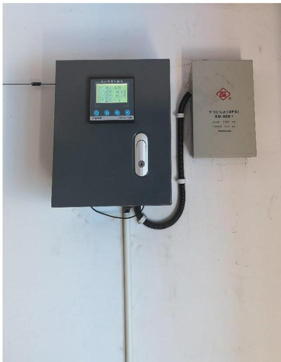
我公司开发的楼栋调平控制器利用 4G 无线网络, 结合物联网云计算平台, 实现温度的远程采集, 现场设备的远程控制。具有手动、时段、恒温多种控制模式, 实现了差异化供热, 改善了不利点温度, 减少了设备磨损, 同时也起到了节能减排的作用。
